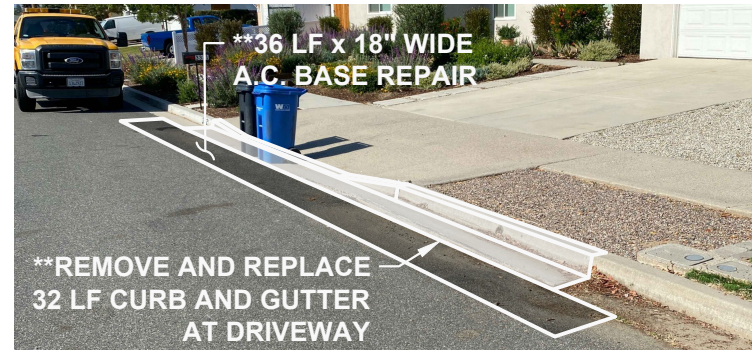
3321 BLACK AVENUE P.C.C. CURB & GUTTER N.T.S.
